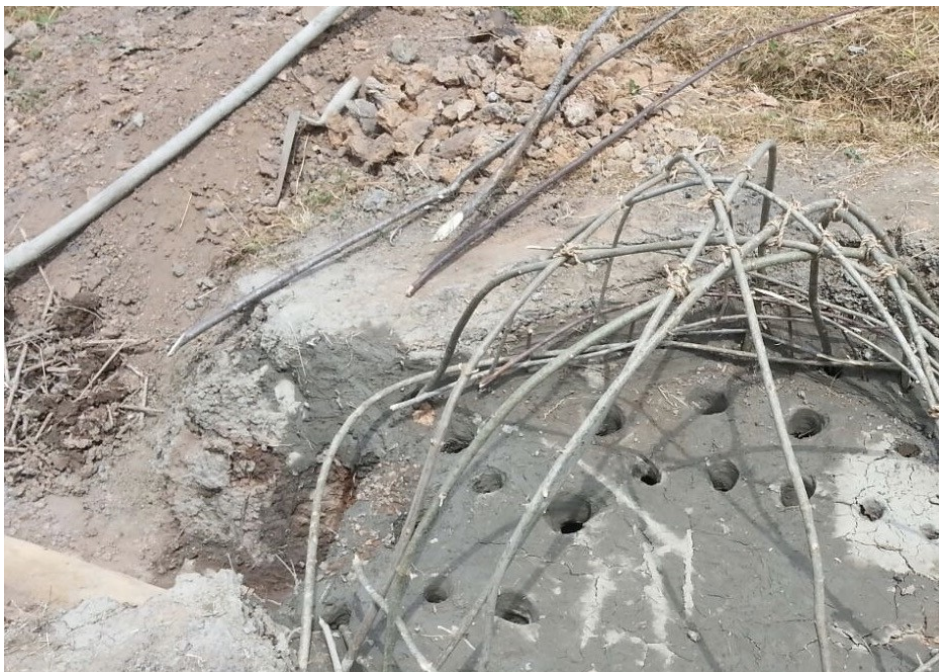
Fig. 1 - Costruzione del forno in terra e paglia.
