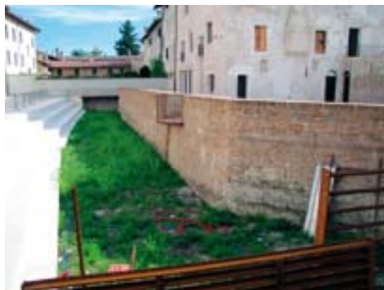
Fig. 31. San Vito al Tagliamento, Borgo Castello: le mura dopo il restauro (Foto Museo Civico di San Vito, luglio 2010).
