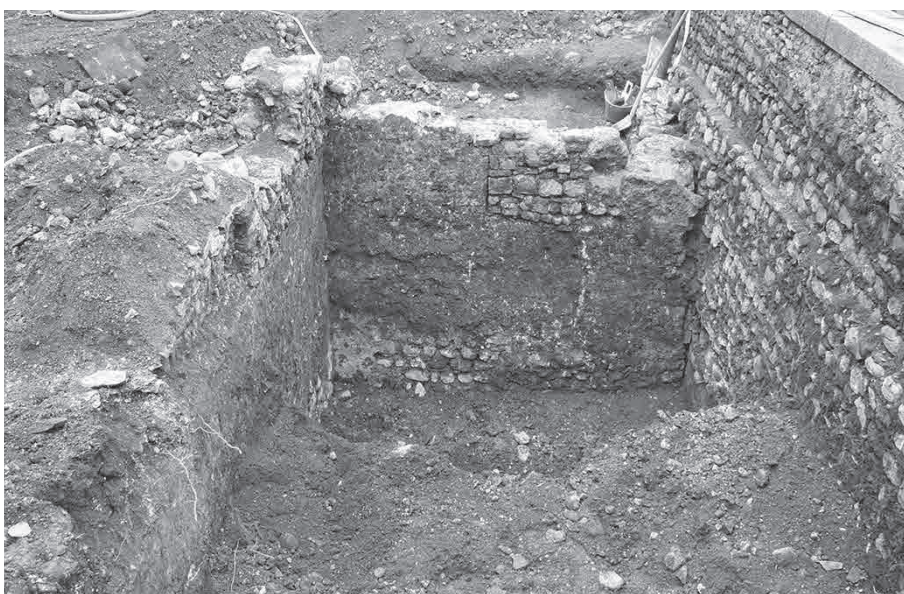
Fig. 29- Colle del Castello, biblioteca Joppi, la struttura muraria interrata, struttura N-W, contro il muro di terrazzamento moderno del colle. - Colle del Castello, biblioteca Joppi, the buried wall structure, N-W structure, against the modern terracing wall of the hill.
