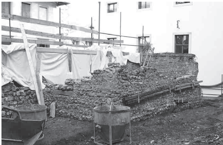
Fig. 30 - Colle del Castello, biblioteca Joppi, la struttura muraria interrata, struttura N-W, vista dall'esterno. - Colle del Castello, biblioteca Joppi, the buried wall structure, N-W structure, seen from the outside.
