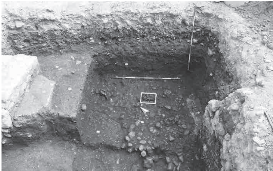
Fig. 4 - Via Mercatovecchio. L'area di scavo al punto 1 dopo l'approfondimento. Sul fondo ciottoli con elementi ceramici di epoca romana US 54. - The excavation area at point 1 after deepening. At the pebbles with ceramic elements from the roman period SU 54.
