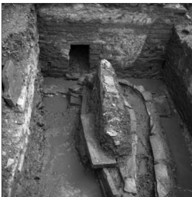
Fig. 5. Aquileia, domus di piazza Capitolo. I condotti di smaltimento e l'apertura nel muro perimetrale est dell'edificio (Archivio Museo Archeologico Nazionale di Aquileia, n. inv. 5009/159).
