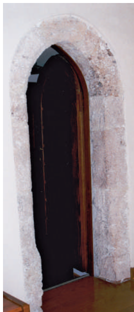
Fig. 14. Una delle due aperture ad arco ogivale messe in luce nel post-terremoto (lato sud del chiostro, primo piano).
