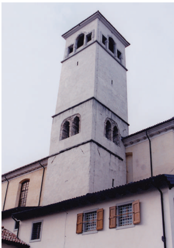
Fig. 8. Le bifore gotiche del campanile messe in luce dopo il terremoto del 1976.
