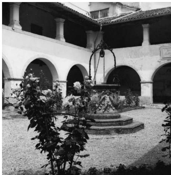
Fig. 9. Particolare del chiostro prima del terremoto del 1976 (Archivio O. Deganutti).
