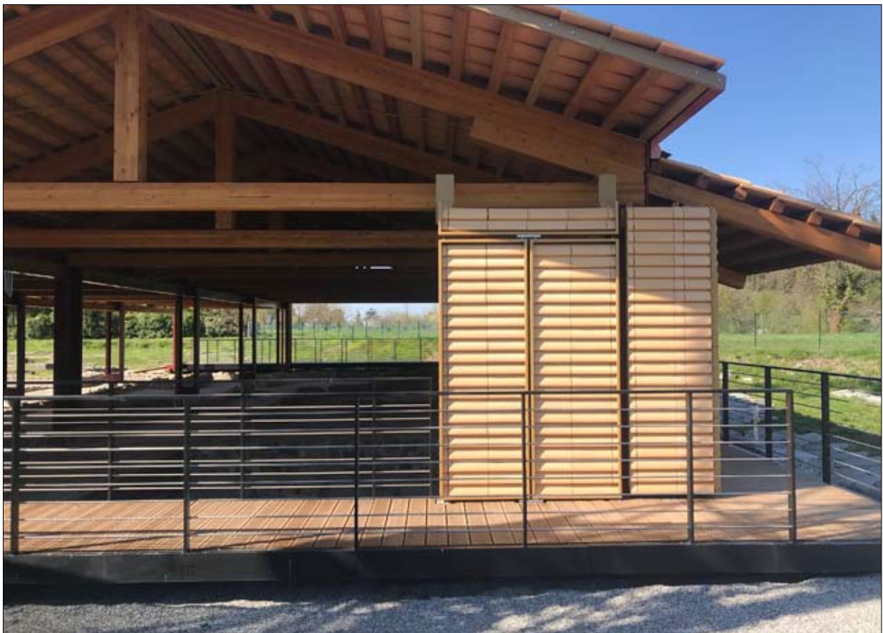
Fig. 5. Aquileia, fondi Cossar. Particolare della struttura di copertura della domus di Tito Macro, attualmente in corso di completamento.
