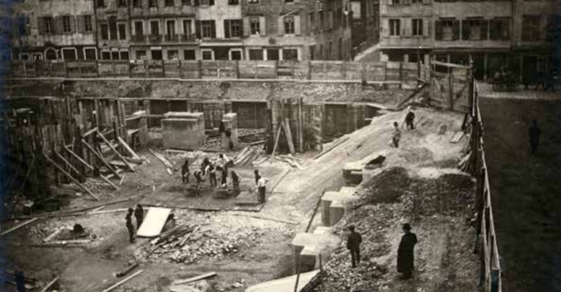
I pilastri di fondazione del Palazzo comunale, 1912 ca. (Udine Civici Musei, Fototeca)
