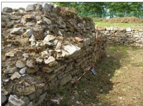
Fig. 19. Nella parte dello spiccatto il nucleo cementizio, non protetto, è maggiormente soggetto a degrado (foto M. Buora).
