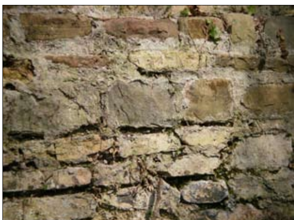
Fig. 23. La tessitura muraria della fondazione: alcune parti di malta moderna sono state aggiunte negli anni Settanta o nei primi anni Ottanta (foto M. Buora).
