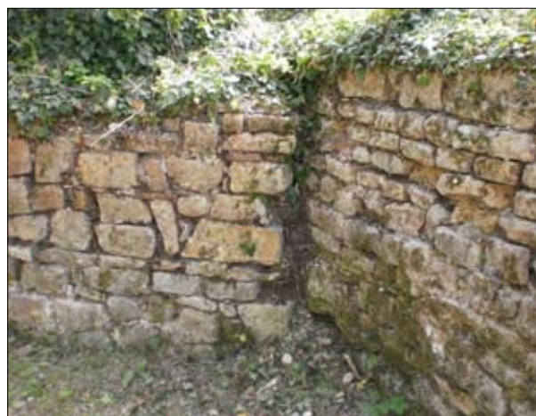
Fig. 29. Si osservi il taglio della costruzione precedente, a sinistra, per l’inserimento della nuova, eseguita in maniera più regolare e ordinata (foto M. Buora).
