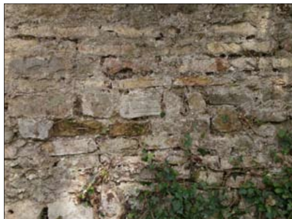
Fig. 24. Come materiale da costruzione è stato reimpiegato anche un pilastro (rotto) di una recinzione presbiteriale (foto M. Buora).
