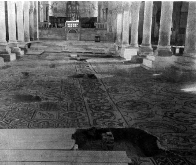
Fig. 9 - Navata centrale dopo lo sterro (da Blason Scarel 1997) Fig. 10 - La stessa dopo l'intervento sulle sepolture (da Fasiolo 1915)
